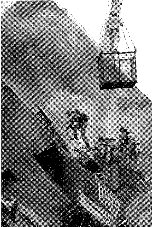
↓ 位於草屯鎮傾倒的七層樓公寓。 ← 救災人員不眠不休的搶救失蹤住戶，精神令人欽佩。
