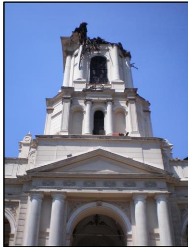
百年的古蹟遭受強震之後，結構仍然完好無損，祇有塔樓的
